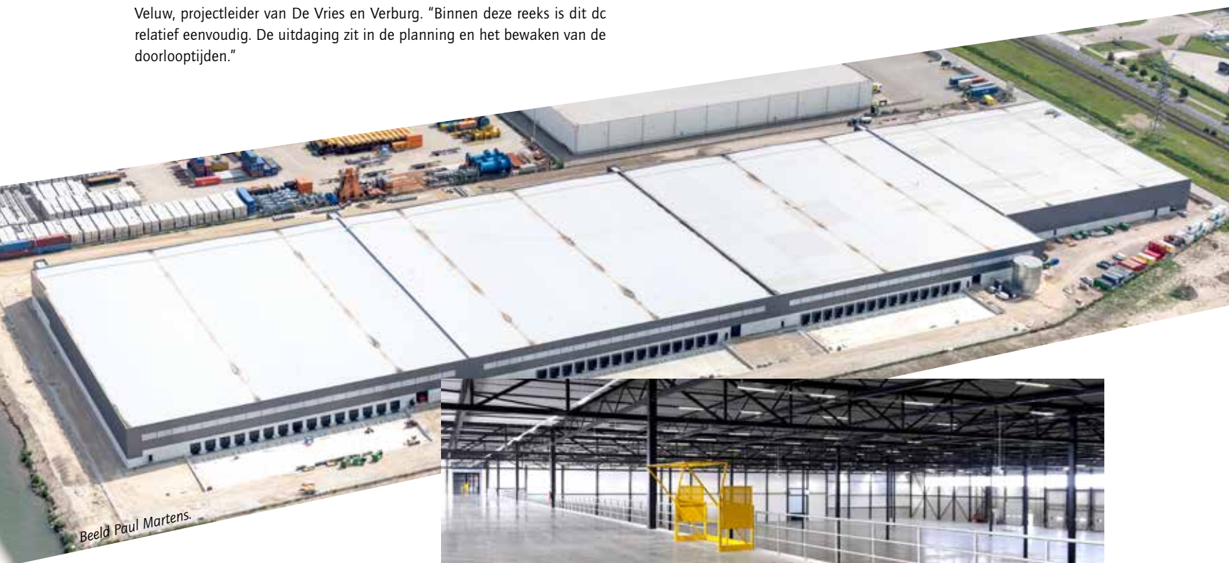
Het dc is verdeeld in vier brandwerende compartimenten.
